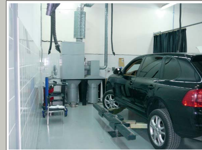
Hochvakuum Filteranlage mit Funkenschutzüberwachung (500 m³/h) für 2 Alu-Arbeitsplätze in der Karosseriewerkstatt.
