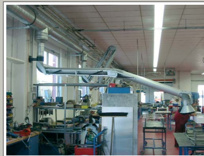
Absaugarm NW 160 – 4 m lang mit Wandkonsole zur Schweißrauchabsaugung als Zentralanlage in einem Industriebetrieb.
