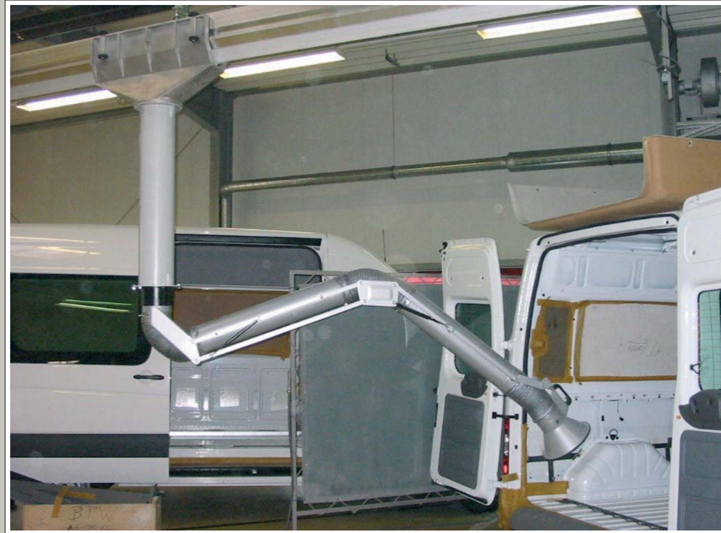
Laufwagen im SSK 290 mit Verlängerungsrohr und Absaugarm NW 160 für die punktuelle Erfassung von Schadstoffen.
