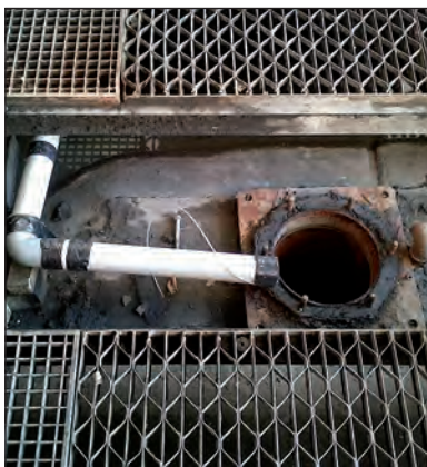
Neues Leerrohr zur Bühnenversorgung
