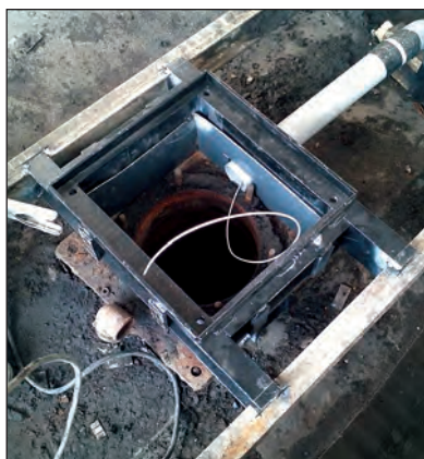
Ausrichtung und Verschalung des neuen Rahmens
