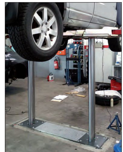
Hebebühne nach erfolgter Montage
