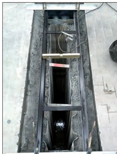
Ausrichtung für Betonierung des neuen Rahmens
