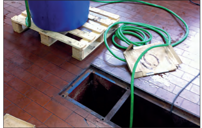
Auspumpen und Reinigen des Kassetteninnenraumes
