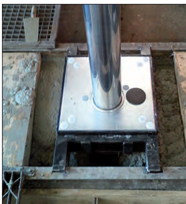
Einbetonieren des neuen Rahmens
