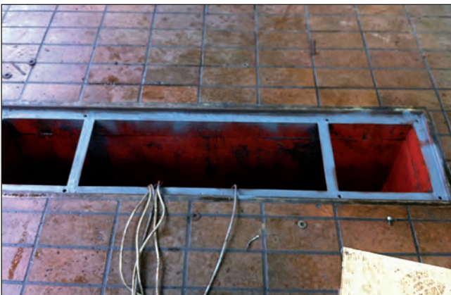
Überarbeitung des Kassettenrahmens
