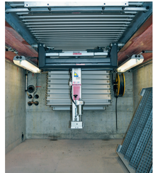
Profil avec cric de fosse Pitlift suspendu
