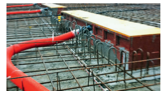
Photo du haut: intégration de cassettes
