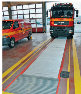
Couverture de fosse fermée
