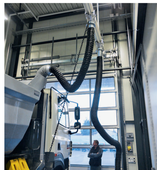
Bild links: Grubenheber Pitlift mit Gelenkspieltester Altus Bild oben: Fertigstahlgrube Rolltec Bild rechts: Absauganlage s.tec
