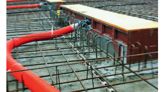
Bild oben: Kassetteneinbau
