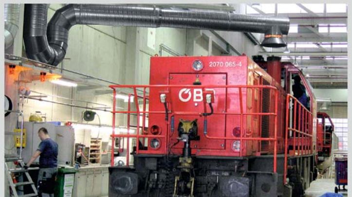
Diesellok-Absaugung mit einem schwenkbaren Auslegearm.
