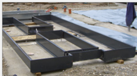
Einbaurahmen für Fahrflächenvarianten mit und ohne Bodenausgleich zum genauen Einpassen der Hebebühne. Durch die vorgefertigten Einfassungsrahmen wird beim Einbau eine hohe Genauigkeit erreicht.
