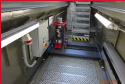
Querverfahrbarer, bodenlaufender R-Grubenheber kann neben dem Grubeneingang geparkt werden.
