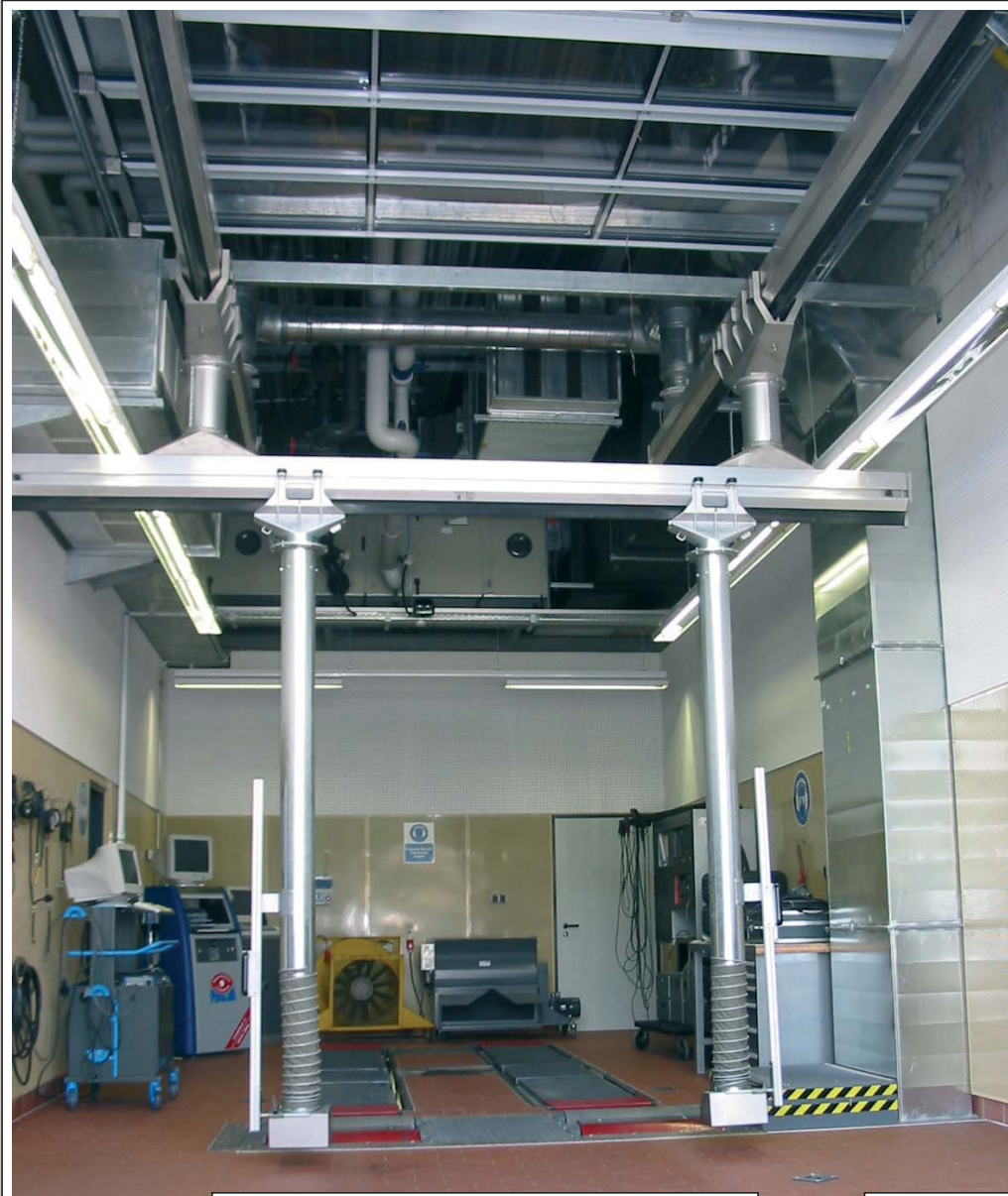
Saug Schlitzkanalanlage SSK 290 im Koordinatensystem verfahrbar für PKW-Leistungsprüfstand mit einer Absaugleistung bis 4.000 m 3 /h und in Hochtemperaturausführung bis 900°C Abgastemperatur lieferbar.
