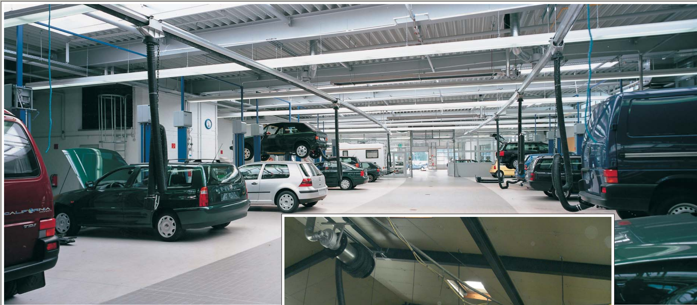
Saugschlitzkanal SSK 150 in gebogener Ausführung mit je drei Laufwageneinheiten in NW 100 und Einzelventilatoren Typ FD.
