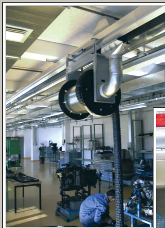
Mechanischer Schlauchaufroller im Saugschlitzkanal Typ SSK 290 verfahrbar.
