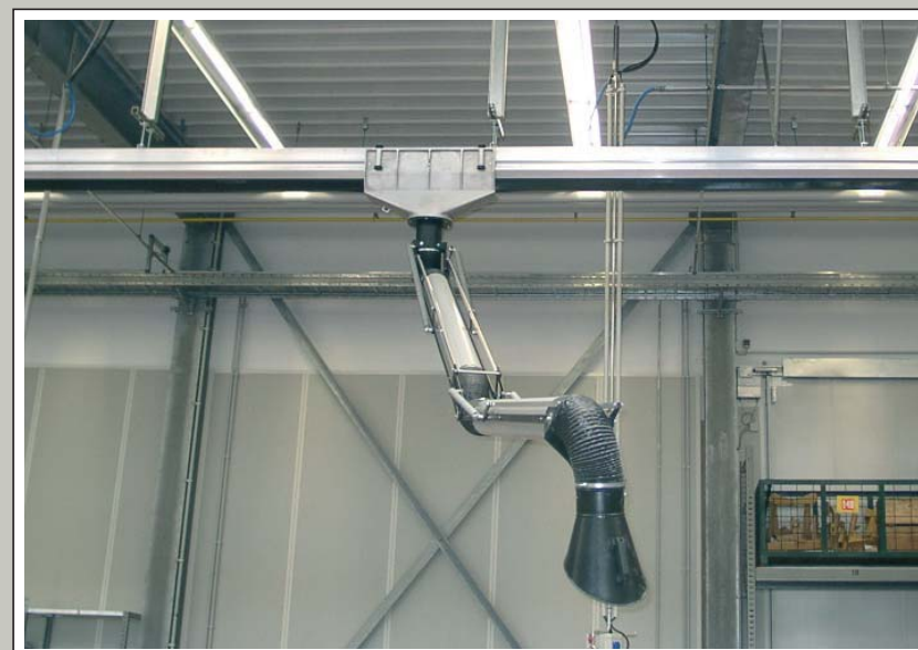
Saugschlitzkanal SSK 290 mit Rohrabsaugarm NW 160 – 4 m – für Schweißrauchabsaugung in der Karosseriewerkstatt.
