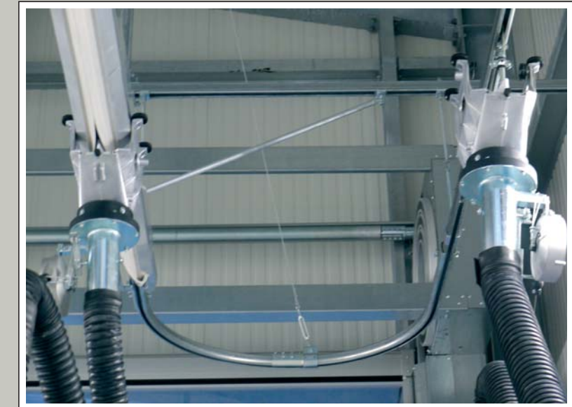
„SLS-Car“ Saugeinheiten in Warte- und Einsatzposition in einer Prüfstraße für die Fahrzeugkontrolle.
